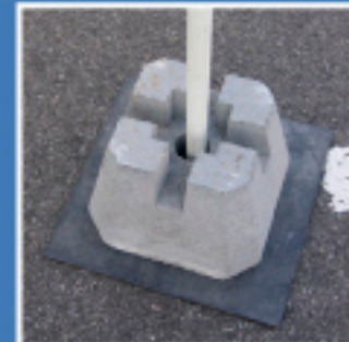
ÉTAPE 5 Insérer la base de béton sur le support de métal. Insérer le winder pole dans le support de métal.
